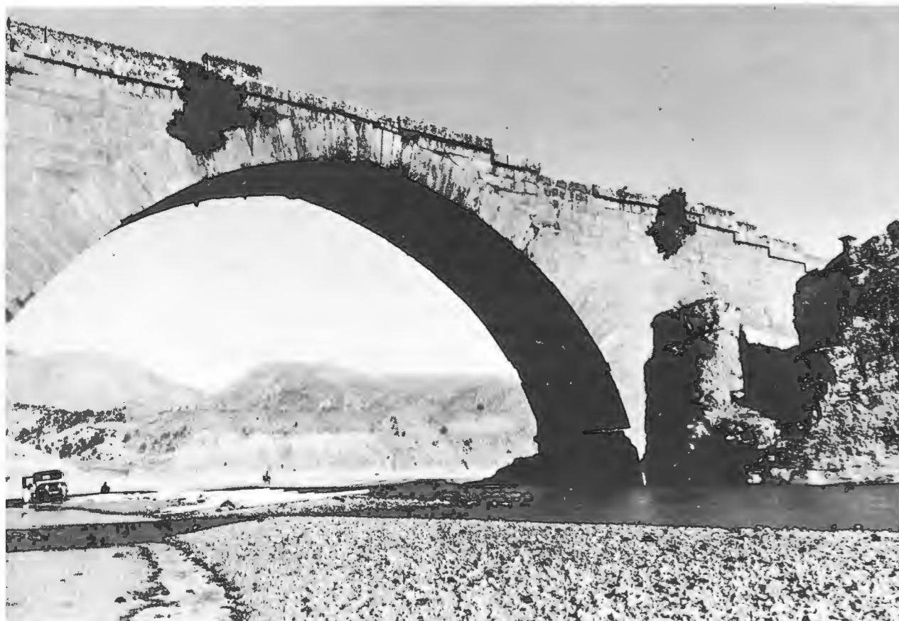
Abb. 82 Kühne Konstruktion des Brückenbogens
